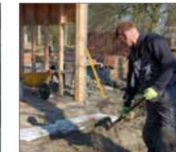
Na plaatsing en aansluiting van de Hydroblob® blokken, brengt u weer een zandlaag van minimaal 10 cm over de blokken aan.
