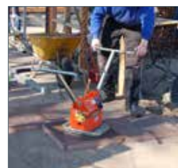
Over het zandbed gaat vervolgens de bestrating.
