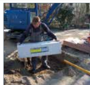
Plaats de Hydroblob® infiltratieblokken rechtopstaand. Zo kunnen ze een hogere druk aan en infiltreren ze het best.
