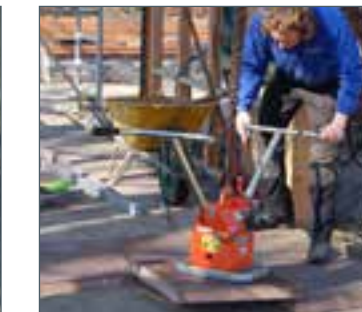
Op de zandlaag plaatst u vervolgens uw bestrating.
