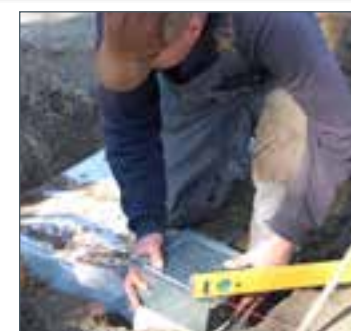
Stel de infiltratieput IP15 zo dat de bovenkant van de put circa 3 mm lager ligt dan de bovenkant van de bestrating.
