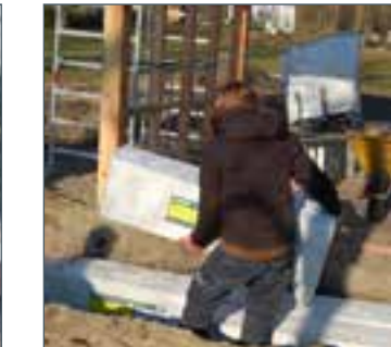
Plaats de Hydroblob® infiltratieblokken rechtopstaand, zo kunnen ze een hogere druk opvangen en infiltreren ze het snelst regenwater.
