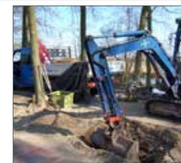
Graaf een gat dat groot genoeg is voor de infiltratieblokken. Zorg er voor dat er over de blokken nog minimaal 10 cm straatzand verwerkt kan worden.
