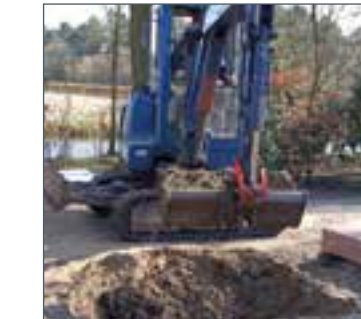
Gat uitgraven ten behoeve van 1 stuks Hydroblob® type BD112 en 3 stuks Hydroblob® type D112 infiltratieblokken.
