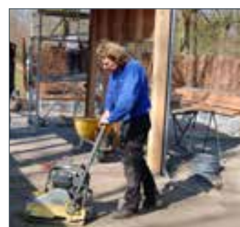
Hierna trilt u het zandbed waar de bestrating op komt te liggen weer stevig aan.
