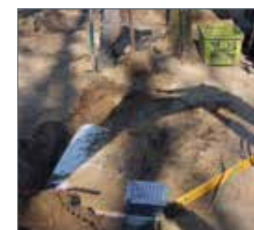
Vervolgens graaft u de 2 infiltratieblokken weer in met minimaal 10 cm straatzand. Het infiltratieputje steekt in dit geval boven het zandbed uit.
