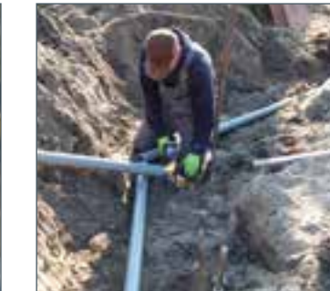
Laat de regenpijp op afschot naar de infiltratieblokken lopen en verlijm ze goed met PVC lijm.
